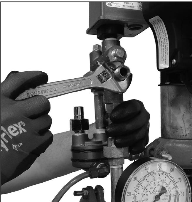
2. Bringen Sie das Formteil vom 26 Zoll/660 mm langen Trimming-Schlauch wie oben gezeigt im Luftverteiler im Auslöse-Trimming an.
