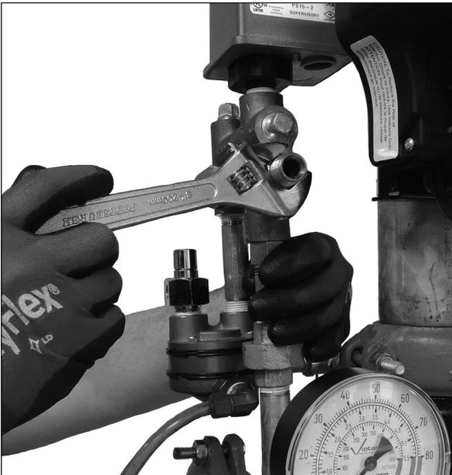
2. Installare il raccordo dalla lunghezza del flessibile del trim da 26"/660 mm nel collettore nel trim dell'attuatore, come mostrato sopra.
