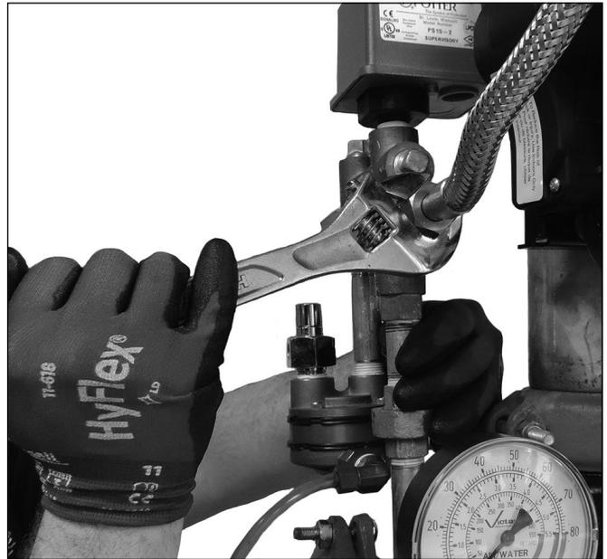
3. Collegare il flessibile del trim da 26"/660 mm al raccordo nel collettore dell'aria, come indicato nei disegni del trim. **NOTA:** verificare che la rondella di gomma sia inserita nel dado del flessibile per evitare perdite d'aria.
