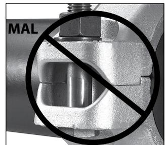
**SIN SEPARACIÓN EN UNA UNIÓN EMPERRADA (LA UNIÓN EMPERRADA DEL LADO OPUESTO PUEDE ESTAR MUY SEPARADA, DEBIDO A QUE NO SE HA ALTERNADO DE FORMA CORRECTA ENTRE AMBAS UNIONES DURANTE EL APRIETE)**
