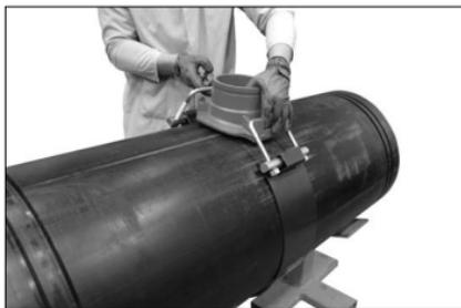
**8. ASEGURE LA BANDA:** En el lado opuesto de la tubería, tome el segundo perno en “U” y engánchelo en el segundo refuerzo de retención del bastidor de la espiga.
