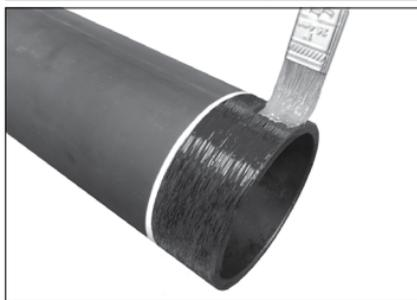
**4. LUBRIQUE LOS EXTREMOS DE TUBERÍA:** Aplique una capa delgada de lubricante en la tubería de HDPE desde el extremo hasta la marca de pintura trazada en el paso 3.
