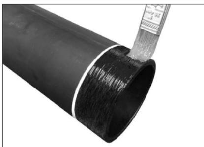
**4. LUBRIQUE EL EXTREMO DE TUBERÍA:** Aplique una capa delgada de lubricante en la tubería desde el extremo hasta la marca de pintura trazada en el paso 3.
