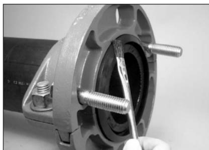
**9. LUBRIQUE EL LABIO:** Después de que la empaquetadura esté en posición, aplique lubricante adicional al labio exterior de la empaquetadura que se sellará en la cara de la brida acoplada. Consulte la tabla "Compatibilidad de lubricantes para empaquetaduras" arriba.
