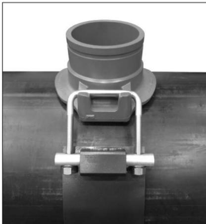
**9. POSICIÓN PARA APRIETE:** Posicione los pernos en “U”, los pasadores y la banda de modo que pueda colocar un dado largo sobre las tuercas para apretarlas.
