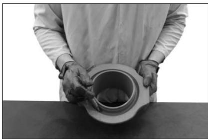
**4. LUBRIQUE LA RANURA:** Lubrique la ranura de acuerdo con la tabla “Compatibilidad de lubricantes para O-rings” en la página 58. Siempre consulte los requerimientos de compatibilidad del lubricante con el fabricante de la tubería.
