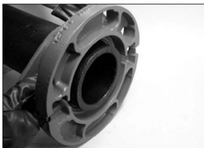
2. **INSTALE LA BRIDA:** Use guantes para manipular el adaptador de brida. Los dientes de sujeción son filosos y pueden causar lesiones. Instale los segmentos del adaptador de brida sobre la tubería de HDPE.
