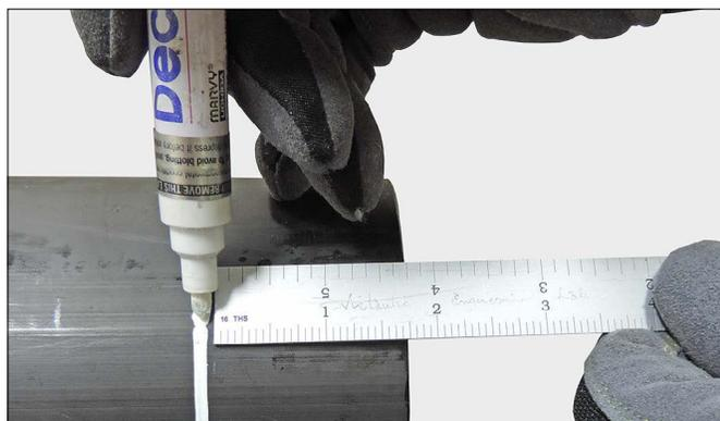
6. Si les marques d'insertion précédentes ne sont pas visibles ou que les tubes ont été remplacés, tracer un signe sur chaque extrémité de tube PEHD avec un crayon et une règle ou un mètre à ruban. S'il n'est pas possible de tracer un signe sur toute la circonférence, tracer au moins quatre signes à intervalle régulier sur la circonférence de chaque extrémité de tube PEHD :
