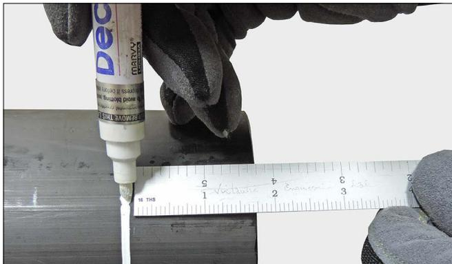
6. Si las marcas de inserción no son visibles o si se han sustituido los tubos, haga una marca en cada extremo del tubo de PEAD con un rotulador y una regla o con cinta adhesiva. Si no puede marcar el tubo en toda su circunferencia, haga por lo menos cuatro marcas a intervalos regulares alrededor del tubo de PEAD:
