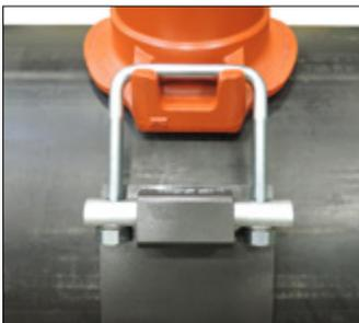
**9. POSITIONNER L'ENSEMBLE POUR LE SERRAGE :** Positionner la courroie et les boulons en U pour pouvoir insérer une douille profonde sur les écrous de serrage.
