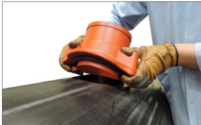
**7. METTRE LA COURROIE EN PLACE :** Accrocher un des boulons en U sur le gousset de retenue du corps du raccord et passer la courroie sous le tuyau pour l'accrocher de l'autre côté.
