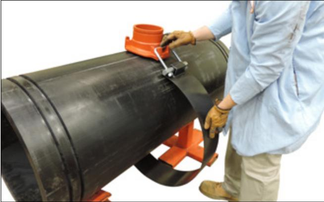
**8. FIXER LA COURROIE :** Sur l'autre côté du tuyau, tirer sur l'autre boulon en U vers le haut et l'accrocher sur l'autre gousset du corps du raccord.
