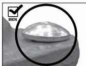
CUELLO OVAL DEL PERNO ASENTADO CORRECTAMENTE
