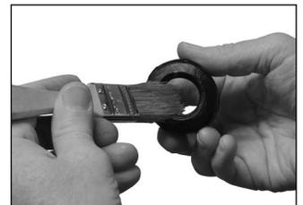
5. **SCHMIERN SIE DIE DICHTUNG:** Tragen Sie eine dünne Schicht Victaulic Schmiermittel oder Silikonschmiermittel auf die Dichtlippen und das Äußere der Dichtung auf. **HINWEIS:** Es ist normal, dass die Oberfläche der Dichtung trüb weiß ist, wenn sie bereits im Einsatz war.
