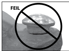
OVAL KRAGE PÅ BOLTEN PLASSERT FEIL
