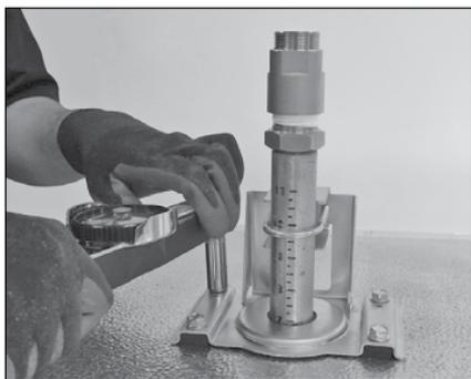
4. Apriete todos los tornillos de brida hexagonales a un par de 40 pulg.-lb/4,5 N•m. NO exceda los valores de par especificados.
