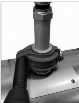
5. Instale el acoplamiento Estilo 109. Consulte las instrucciones de instalación del acoplamiento Installation-Ready Estilo 109.
