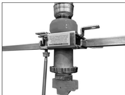
4. Con una broca T25, apriete el tornillo de ajuste a un par de 80 pulg.-lb/9,0 N•m (hasta que el tornillo de ajuste haga contacto metal con metal con la parte inferior de la compuerta). **NOTA:** La boquilla reductora del rociador se puede ajustar con el tornillo de ajuste después de instalar la pared o el cielloraso.
