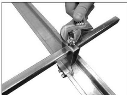
**5.** Apriete el tornillo de mariposa en la parte superior de cada conjunto de soporte de extremo a un par de 36 pulg.-lb/4 N•m (entre  $\frac{1}{2}$  y  $\frac{3}{4}$  de vuelta después de apretar con la mano).
