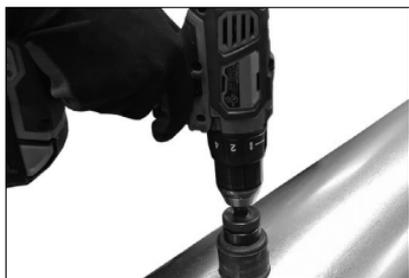
1. Taladre un agujero de 1 ½ pulg./38 mm en la superficie del conducto en la ubicación deseada.
