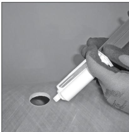
**3.** Use guantes protectores durante esta fase de la instalación. Aplique una capa de  $\frac{1}{8}$  –  $\frac{1}{4}$  pulg./ 3 – 6 mm de adhesivo a la superficie de acoplamiento del bloque de montaje y a un área de 6 x 6 pulg./152 x 152 mm alrededor del orificio cortado en el conducto. Vea la lista de adhesivos recomendados en la tabla anterior. **NOTA:** Victaulic® no suministra el adhesivo.
