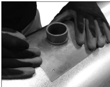
3a. Verifique que la abertura del soporte esté alineada con el orificio en el conducto.
