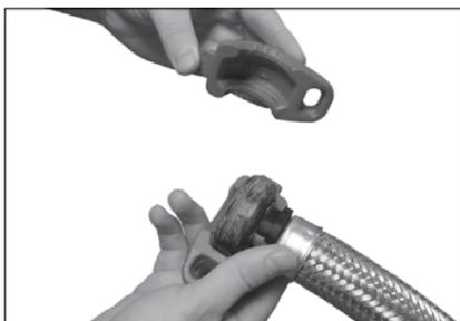
8. Coloque la junta lubricada en la entrada de la manguera flexible y ponga las carcasas del acoplamiento Estilo 108 encima. Verifique que la junta asiente perfectamente en cada carcasa y que las patillas se metan en el espaciador.
