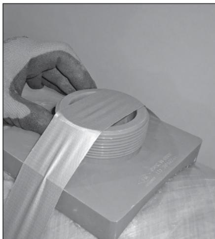
**5.** Establezca el bloque de montaje en su sitio. Utilizando cinta para conductos, fije el bloque de montaje al conducto con cinta adhesiva en un lado y pásela por encima del bloque para envolverlo y pegue la cinta en el lado opuesto. El conjunto no debe manipularse durante al menos 24 horas para que el adhesivo se endurezca.
