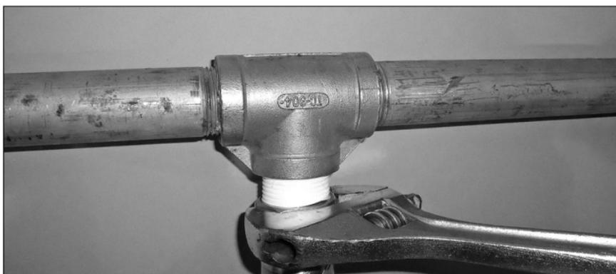
1. Aplique compuesto para juntas o cinta selladora de roscas de PTFE a la boquilla de la manguera flexible de acero inoxidable, siguiendo las instrucciones del fabricante del compuesto para juntas o la cinta selladora de roscas. Apriete la manguera en la conexión de la línea de derivación utilizando una llave de tubo en la tuerca de la manguera flexible de acero inoxidable.
