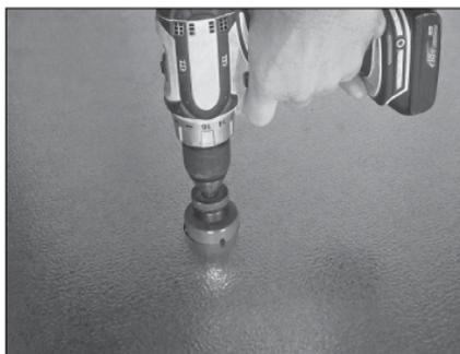
1. Perfore un orificio en el cielorraso o la pared de congelador. Use una sierra de calar de 2 pulg. para los rociadores secos V36 y V40 y una sierra de 2 5/8 pulg para los rociadores secos V33.
