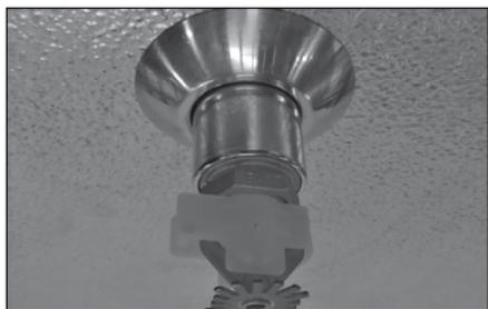
3. Instale el protector de la ampolla en el rociador hasta que el sistema de rociadores sea puesto en servicio. Proceda con precaución al reinstalar el protector de ampolla para no dañar la ampolla, el deflector ni los brazos del marco. NO use herramientas para poner el protector de ampolla.
