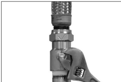
1. Afloje despacio y retire la toma del adaptador Estilo AB6. Deje que se vacíe el conjunto.
