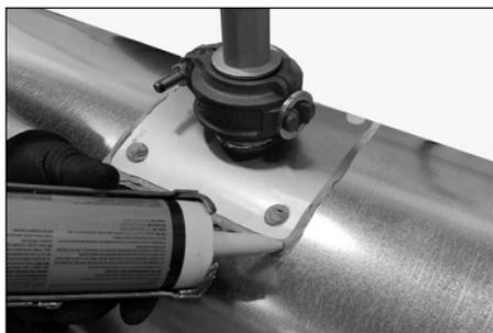
6. Aplique masilla/sellador de conductos para cubrir cualquier espacio entre el soporte y el conducto. Siga siempre las instrucciones del fabricante del sellador/masilla para conductos en lo que se refiere a tiempos de curado.
