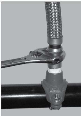
2. Antes de la instalación, confirme que el sello en el interior de la tuerca de la manguera flexible esté posicionado y no tenga daños. Conecte la tuerca a la boquilla adaptadora, como se muestra a la izquierda.
