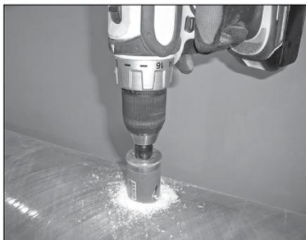
1. Taladre un agujero de 1 ½ pulg./38 mm en la superficie del conducto en la ubicación deseada.
