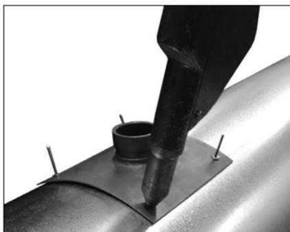
5. Con una remachadora, instale los cuatro remaches.
