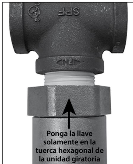
2. Aplique pasta para juntas que no se endurezca o dos o tres vueltas de sellador de rosca PTFE a las roscas macho de la entrada del rociador seco Serie DRY-SC/VS1, siguiendo las instrucciones del fabricante de la pasta o de la cinta.
