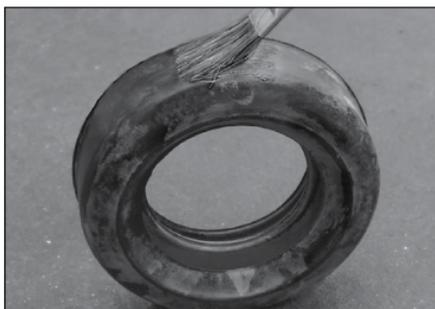
7. Aplique una fina capa lubricante compatible, como lubricante Victaulic® o lubricante de EPDM a los labios de sello y al exterior de la junta. Se puede emplear grasa de silicona (el aerosol de silicona no es un lubricante compatible). Es normal que la junta tenga una apariencia blanca nebulosa después de haber estado en servicio.
