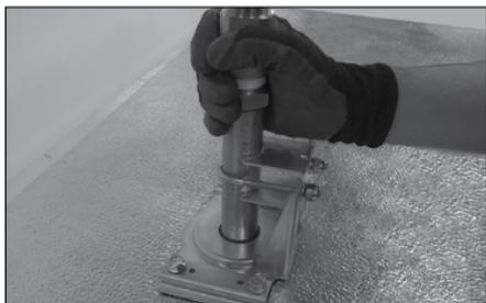
2. Deslice el cilindro del rociador seco V33, V36 o V40 hasta la posición deseada.
