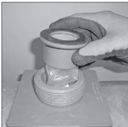
**7.** Si se requiere un conjunto de manga protectora de polietileno en aplicaciones corrosivas, meta el conjunto de la manga por el orificio del bloque de montaje y el conducto. Asegúrese de que la manga se introduzca por completo en el orificio del conducto para evitar que se dañe durante la instalación de la unión.
