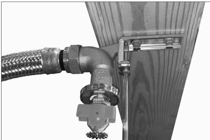
2. Use el tornillo de ajuste para subir o bajar el conjunto de codo reductor de perfil bajo/rociador del soporte Estilo AB13.
