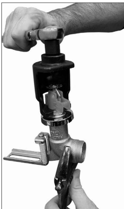
1. Instale el rociador siguiendo las instrucciones de instalación del fabricante. Para rociadores Victaulic, consulte las Instrucciones de Instalación y Mantenimiento I-40 de Rociadores Automáticos Victaulic® FireLock™, que se pueden descargar escaneando el código QR abajo.
