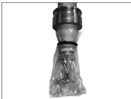
3. Reemplace la bolsa del rociador. **NOTA:** Las bolsas de rociador se deben reemplazar regularmente para que no se acumulen depósitos pesados de residuos. Observe todos los requisitos de la NFPA y la autoridad competente sobre mantenimiento de las bolsas y los rociadores.
