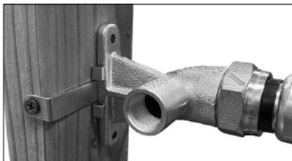
1. Instale el soporte de montaje desplazado opcional del Estilo AB14 al montante de pared empleando un tornillo o clavo para paneles de yeso (diámetro #8). El soporte de montaje desplazado debe estar en pleno contacto con el montante de la pared. **NOTA:** Victaulic no suministra tornillos ni clavos para placas de yeso. Es responsabilidad del diseñador del sistema especificar las fijaciones adecuadas.
