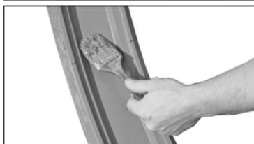
**2b. LUBRIQUE LA EMPAQUETADURA Y LOS SEGMENTOS:** Aplique una capa delgada de lubricante compatible, lubricante Victaulic o grasa de silicona a los labios de sello y el exterior de la empaquetadura y a las superficies interiores de ambos segmentos del acople (la silicona en aerosol no es un lubricante compatible).
