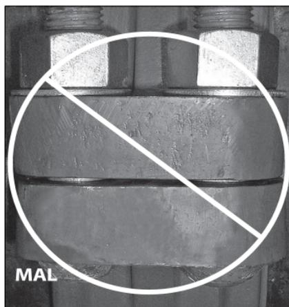
9. Inspeccione visualmente el cierre empernado de cada unión para verificar que haya contacto metal con metal en toda la sección del cierre empernado, como se describe en el paso 8 de la página anterior.
