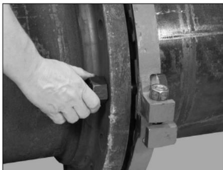
**9. UNA EL ESTILO W741 Y LA BRIDA ACOPLADA:** Inserte los pernos de montaje, instalados en el paso 8, en los orificios de la brida acoplada. Apriete una tuerca en cada perno para evitar que se salgan.
