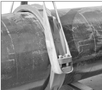
**6. INSTALE LOS SEGMENTOS:** Usando un método de sujeción con bandas similar a los ejemplos que se muestran arriba, con un perno lubricado instalado en cada orificio de perno, instale los segmentos sobre la empaquetadura. Verifique que las cuñas de los segmentos encajen completamente en la ranura de cada extremo de tubería preparado. Continúe apoyando los segmentos mientras se prepara a instalar las arandelas planas y las tuercas.
