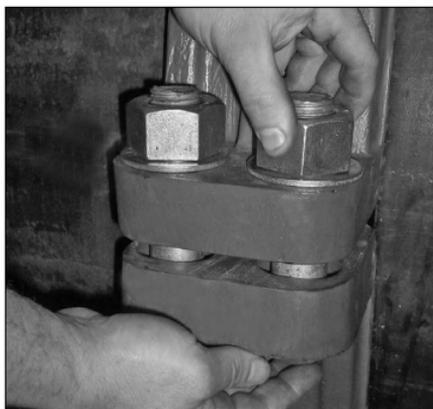
**7. INSTALE LAS ARANDELAS PLANAS/ TUERCAS:** Instale una arandela plana en el extremo de cada perno, luego enrosque una tuerca en cada perno con la mano. **NOTA:** Verifique que el cuello ovalado de cada perno se asiente correctamente en el orificio del perno.
