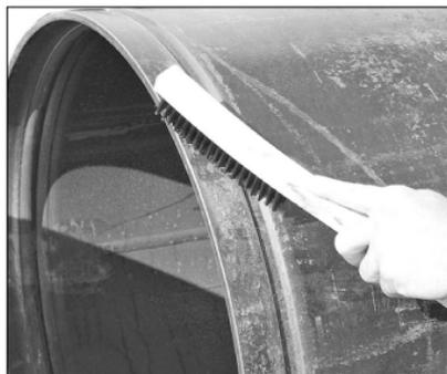
**9.** Limpie la superficie exterior de la tubería, desde la ranura al extremo, para eliminar todo el aceite, la grasa, la pintura suelta y la suciedad.
