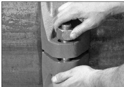
**6a. INSTALE LOS SEGMENTOS:** Instale los segmentos sobre la empaquetadura. Verifique que las cuñas de los segmentos encajen completamente en la ranura de cada extremo de tubería preparado. Continúe apoyando los segmentos mientras se prepara a instalar los pernos y tuercas lubricados.
