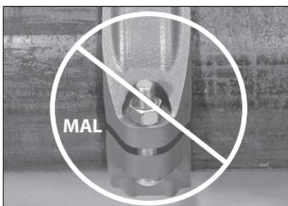
8. Inspeccione visualmente el cierre empernado en cada unión para verificar que haya contacto metal con metal en toda la sección del cierre empernado, como se describe en el paso 7 de la página anterior.
