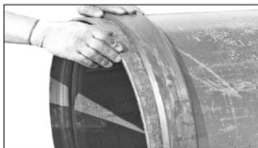
**3. POSICIONE LA EMPAQUETADURA:** Posicione la empaquetadura sobre los extremos de tubería preparados. Verifique que ninguna parte de la empaquetadura sobresalga del extremo de tubería preparado.
