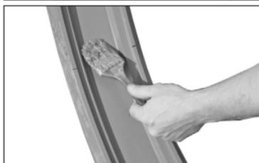
**2b. LUBRIQUE LA EMPAQUETADURA Y LOS SEGMENTOS:** Aplique una capa delgada de lubricante compatible, lubricante Victaulic o grasa de silicona a los labios de sello y el exterior de la empaquetadura y a las superficies interiores de ambos segmentos del acople (la silicona en aerosol no es un lubricante compatible).
