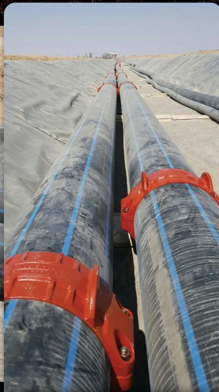
Ao considerar um método de junção de tubo para suas 2,5 milhas | 4 quilômetros de comprimento, 24" | 630 mm OD PEAD tubulação de resíduos na mina de urânio Husab, a Husab Joint Venture buscou uma solução que permitiria a facilidade de manutenção futura e uma instalação inicial rápida.
