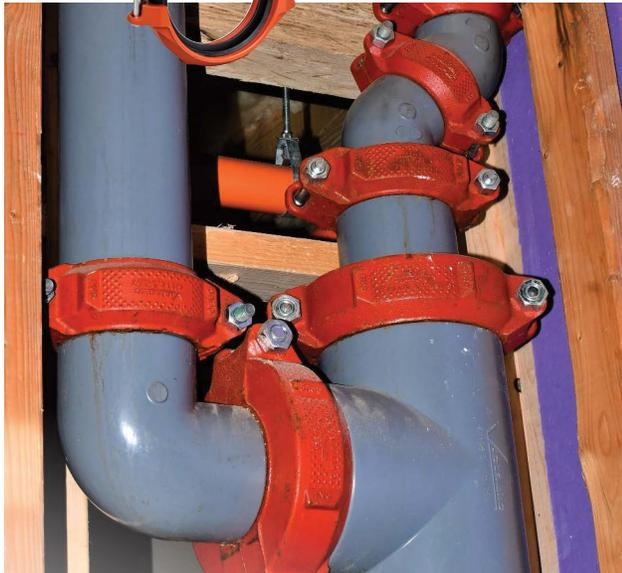
Victaulic ofrece la primera y única solución ranurada de la industria para tuberías de CPVC/PVC cédula 40 y 80. Es el método más rápido y limpio para instalar tuberías de CPVC/PVC. Elimina el tiempo de secado y los productos químicos y olores asociados a los métodos tradicionales.
