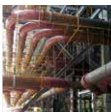
ELEKTROWNIA HUNAN YIYANG Yiyang, Hunan, Chiny
