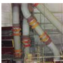
ELEKTROWNIA SPRINGERVILLE Springerville, Arizona, USA
