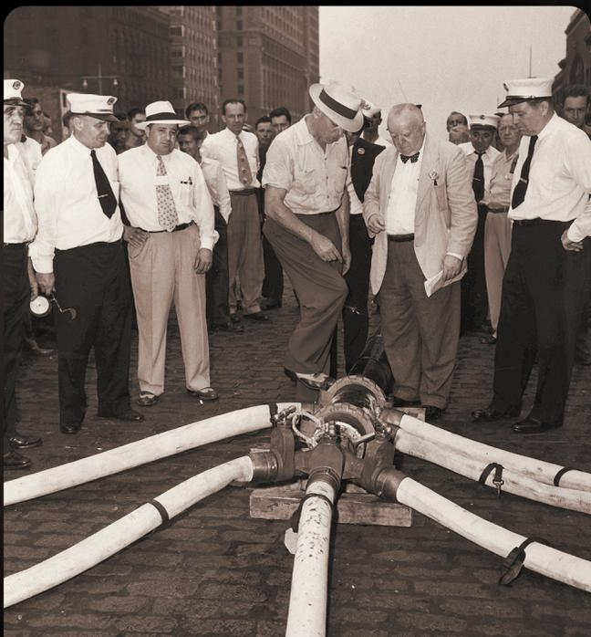
Una motobarca-pompa di New York ha pompato acqua dal fiume River a una distanza di 305 m | 1.000ft lungo un tubo in materiale leggero con sezione 8" | DN200 che una squadra antincendio costituita da giovani promesse aveva assemblato con giunti Victaulic. Nel 1952, Underwriters' Laboratories (UL) ha approvato i giunti e i raccordi Victaulic per l'uso con sistemi antincendio.
