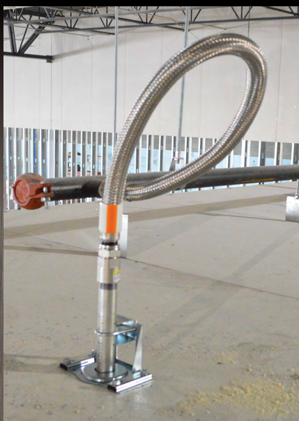
Hengende sprinklerhode med hylse og kant
