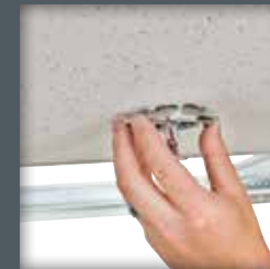
Install escutcheon — done!*
