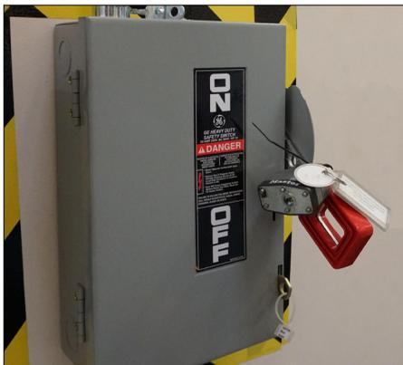
6b. Couper l'alimentation principale de l'outil (panneau du disjoncteur, sectionneur à lames, etc.). Cadenasser le dispositif de commutation en position OFF pour éviter toute mise sous tension accidentelle.
