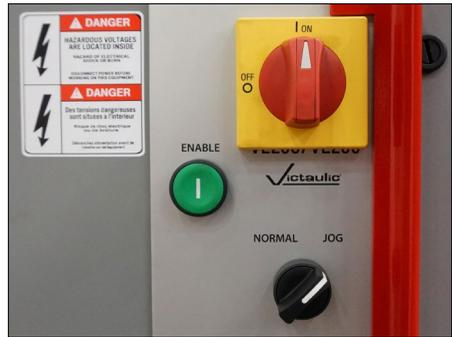
6. Portare l'interruttore di alimentazione a lato della macchina sulla posizione "ON". Portare il selettore a lato della macchina sulla posizione "JOG".
