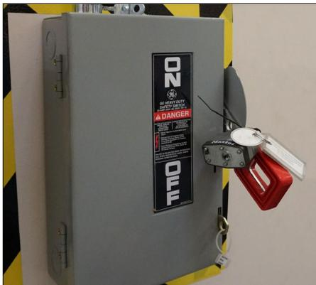
6b. Togliere tensione alla macchina (quadro interruttori principale, sezionatore ecc.). Bloccare l'interruttore in posizione "OFF" per prevenire l'inserimento accidentale.
