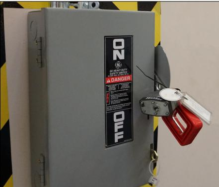
8b. Schalten Sie die Hauptstromversorgung zum Werkzeug ab (Schutzschalter, Messerschalter usw.). Verriegeln Sie den Schalter in Position „OFF“, um versehentliches Einschalten zu verhindern.
