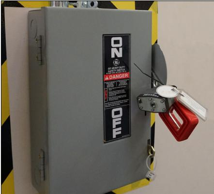
Schalten Sie vor Einstellungen oder Wartungsarbeiten am Werkzeug die Hauptstromversorgung ab (Hauptschutzschalter, Messerschalter usw.). Verriegeln Sie den Schalter in Position „OFF“, um versehentliches Einschalten zu verhindern.
