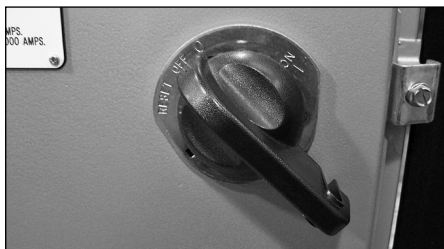
7. Құралдың бүйір жағындағы іске қосу ауыстырып-қосқышын «ӨШІРУЛІ» күйіне бұраңыз.
