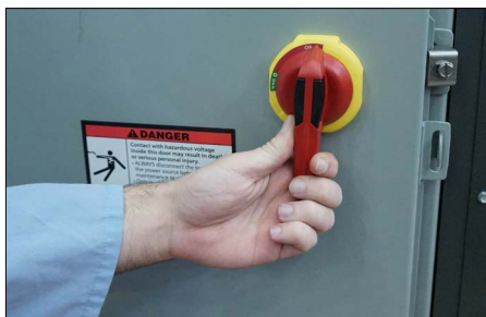
6. Ustawić wyłącznik zasilania znajdujący się z boku narzędzia w położeniu „ON” (WŁ.).
