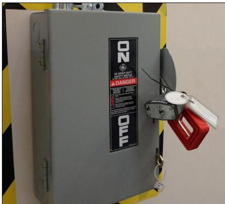
Antes de realizar cualquier ajuste en la herramienta o darle mantenimiento, apague la alimentación principal (panel disyuntor de circuito principal, interruptor de cuchilla, etc.). Bloquee el interruptor en la posición “OFF” para evitar que sea accionado accidentalmente.
