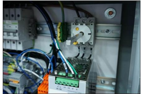
7. Abra el gabinete principal aflojando el tornillo en los dos soportes del gabinete principal. Empuje la palanca en la parte inferior de la manija mientras la gira hacia la derecha para abrir el gabinete principal. Invierta cualquiera de las dos líneas entrantes en la parte superior del desconector de alimentación principal (ubicado al lado superior derecho dentro del gabinete).
