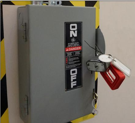
6. Apague la alimentación eléctrica principal a la herramienta (panel disyuntor de circuito, interruptor de cuchilla, etc.). Bloquee el interruptor en la posición "OFF" para evitar que sea accionado accidentalmente.
