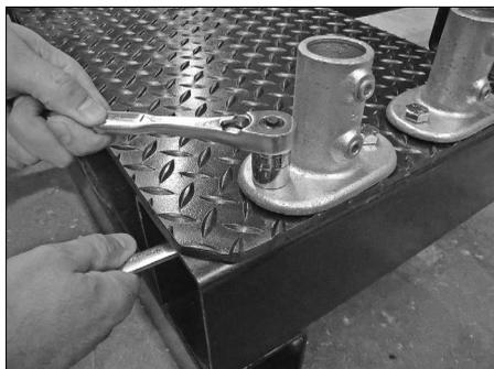
**13c.** Aperte a porca sextavada completamente até a anilha de pressão ficar comprimida. Repita este passo para cada ponto da base dos corrimões.
