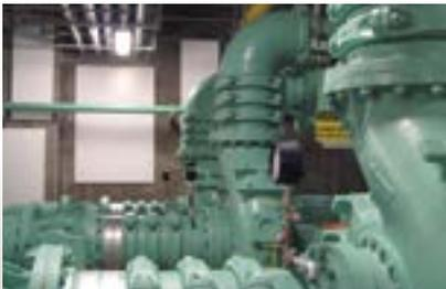
Los acoples Victaulic Estilo 31, ensamblados con tuberías de hierro dúctil AWWA ranuradas por corte de radio flexible, permiten el movimiento controlado de la tubería dentro del acople mientras mantienen un sello firme y una unión autorrestringida. Colocar acoples Estilo 31 muy próximos a equipos mecánicos atenúa las vibraciones del sistema.
